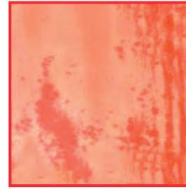
Konteynırlardaki doğal oksitlenmiş/rengli oksitlenmiş alüminyum yüzeylerde materyal saldırısı. Neden: Müsaade edilmeyecek kadar yüksek yıkama çözeltisi
