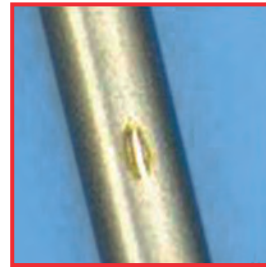
Temas sonucu korozyon: Paslanmaz çelik/paslanmaz çelik
